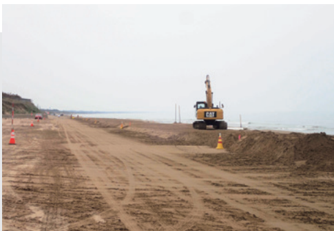
(写真1) 千里浜の侵食に対する復旧工事
